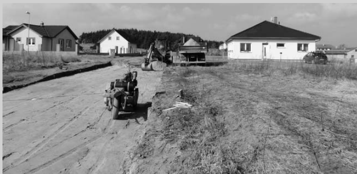
Práce firmy VOaKA Kutná Hora na další části spodní stavby komunikace v lokalitě Za Humny
